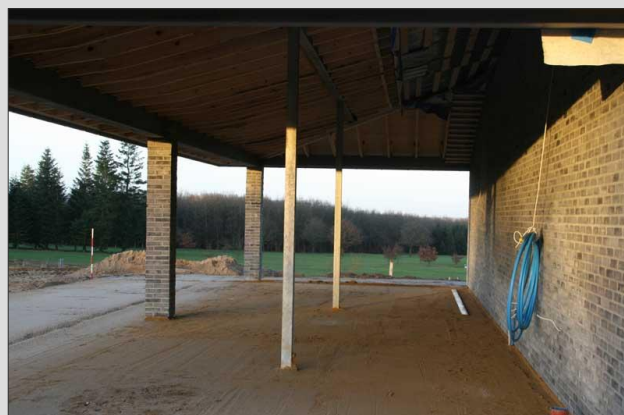
Terrassen mod sydvest er blevet planeret og gjort klar til belægning.
