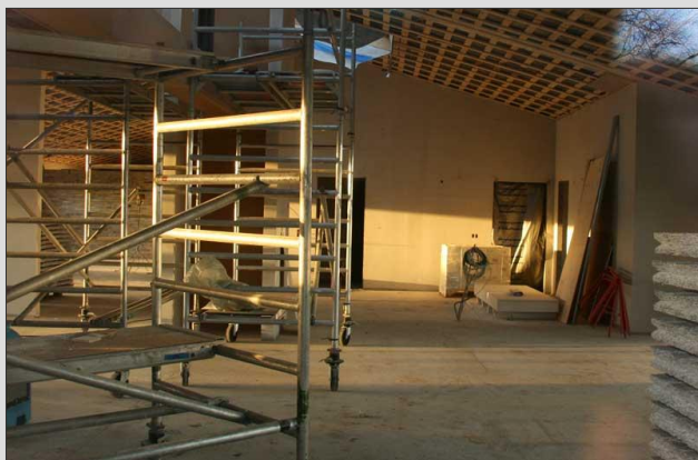
Loftsbeklædningen er parat til at blive monteret.
