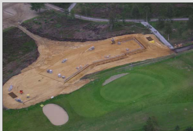
Byggepladsen og hul 18 set fra luften d. 25. aug. 2008
